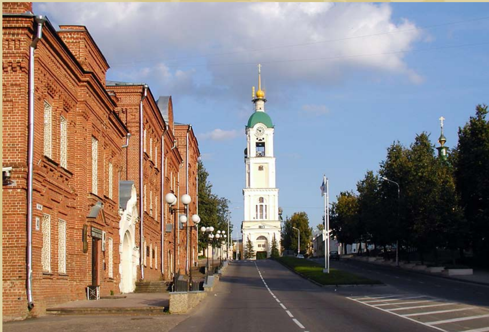
7-1. Здание управления РФЯЦ-ВНИИЭФ 7-1. The RFNC-VNIIEF Administration Building
