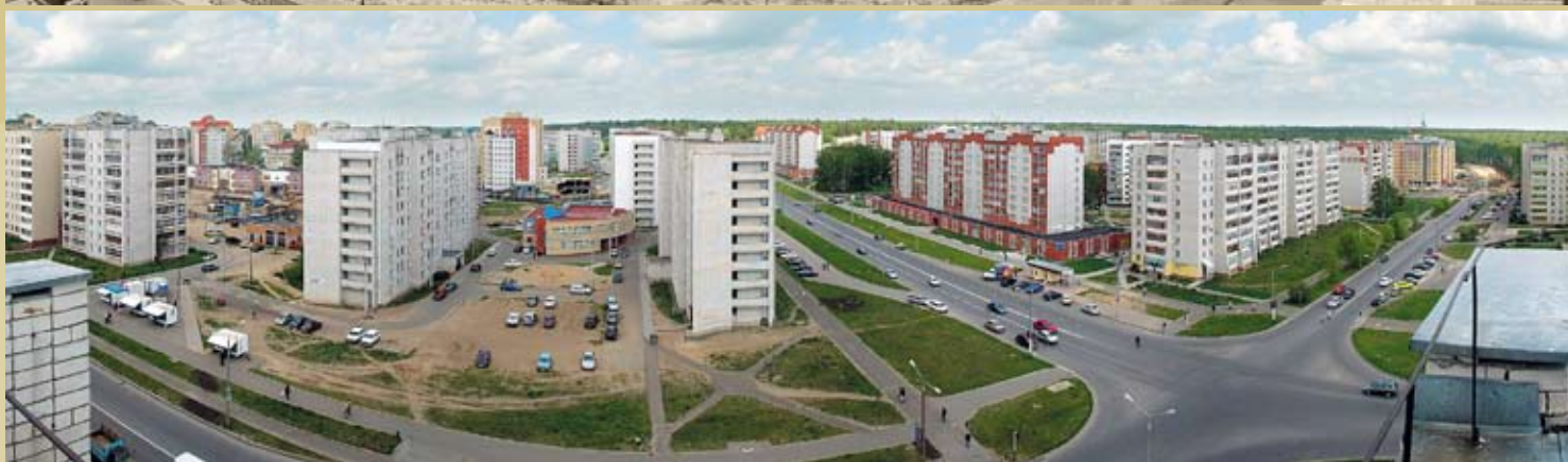
8-11. Строительство города 8-11. The City Building Sites
