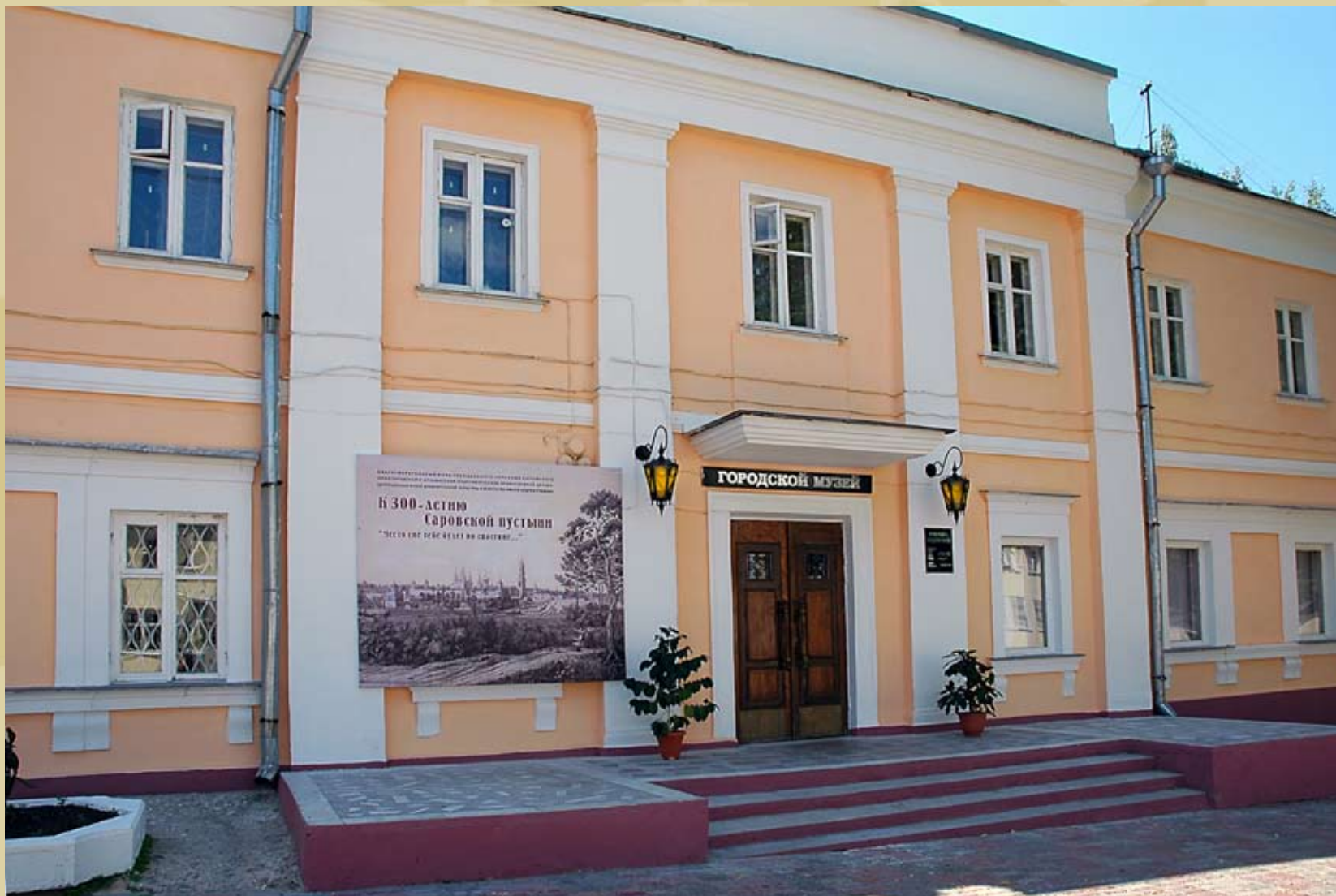
8-9. Здание городского музея 8-9. The City Museum Building
